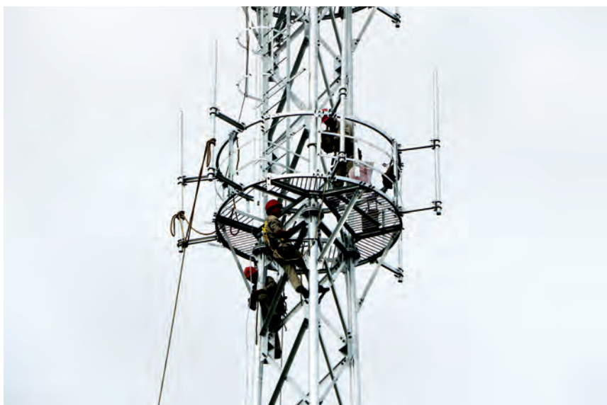
2019年,铁塔绍兴市分公司推进5G基站建设
